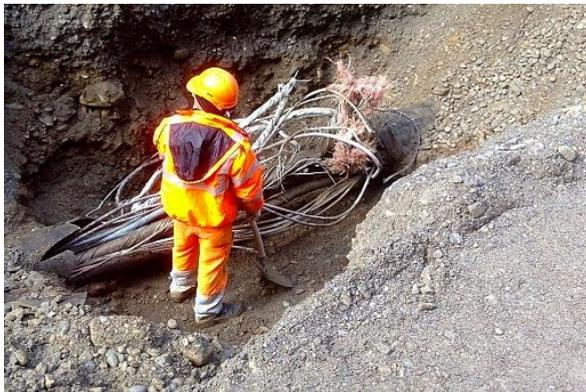
Abbildung 1 Leitungsschaden<sup>2</sup>
